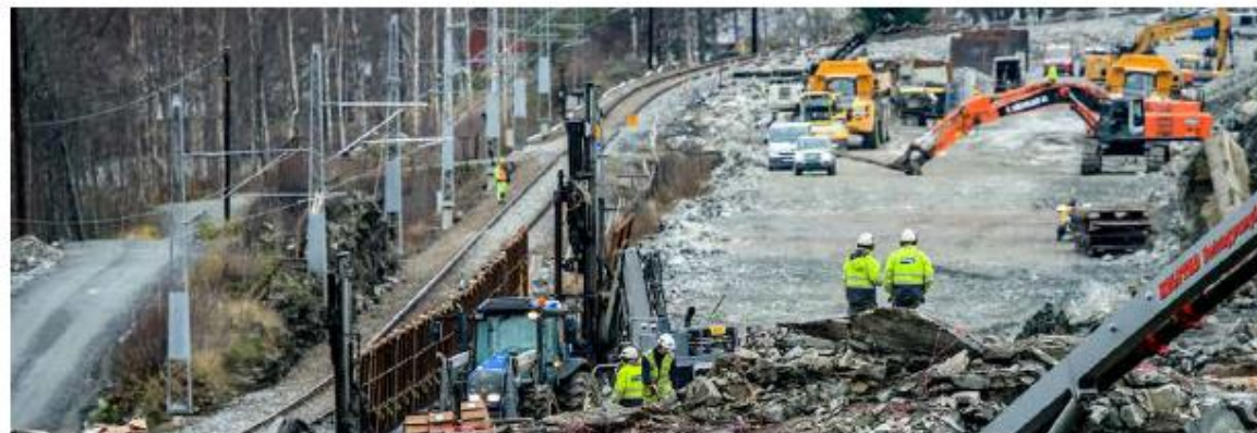
Fra byggingen av E6 sør for Hamar ved Mjøsa. Denne strekningen står for lengst ferdig. FOTO: STEIN J. BJØRGE
